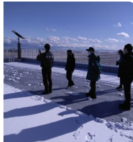
可视化确认掩体周围的损坏情况
